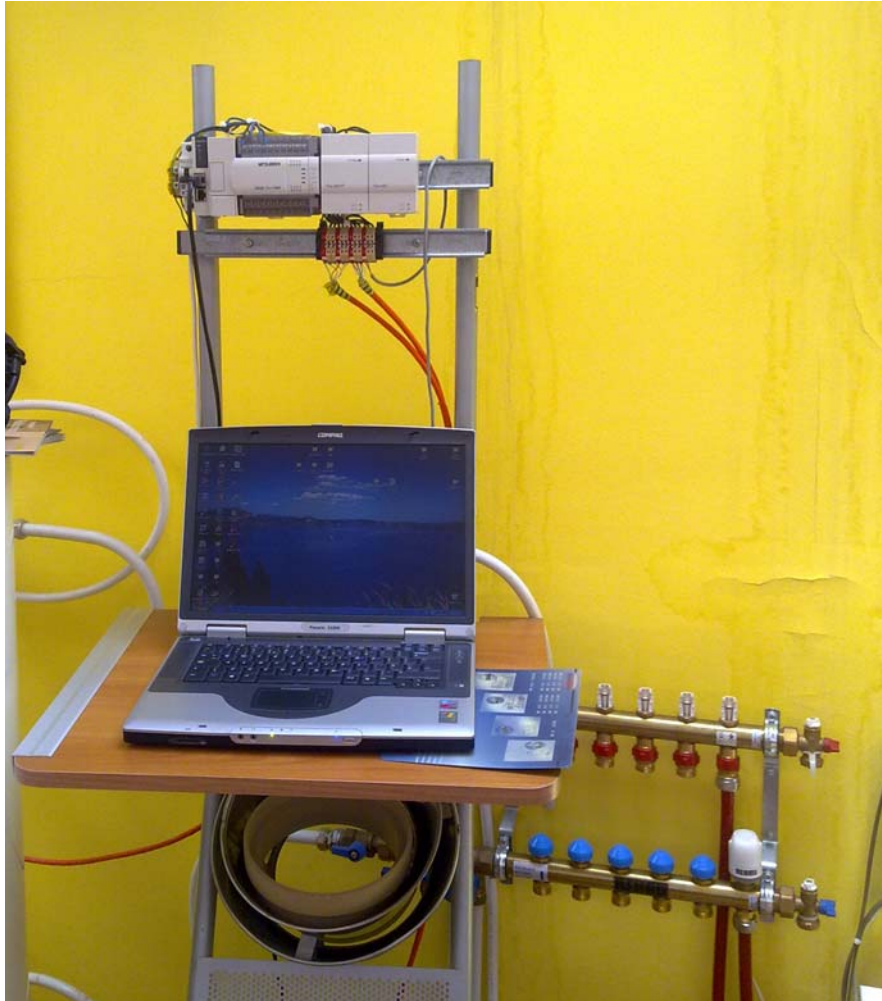
Слика 3 - Уређај за праћење, аквизицију и управљање параметрима рада инсталације
