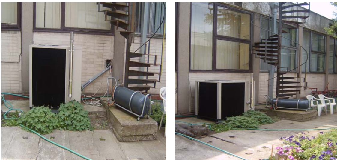
Слика 2 - Апсорциона топлотна пумпа GAHP-AR на природни гас/ТНГ
